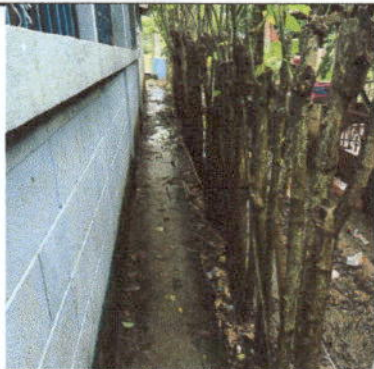
Foto 5: Pintura en muros exteriores e interiores
