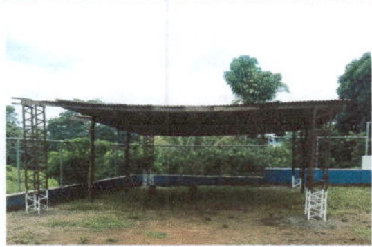
Foto 2: Sustitución de estructura de soporte de madera por metal
